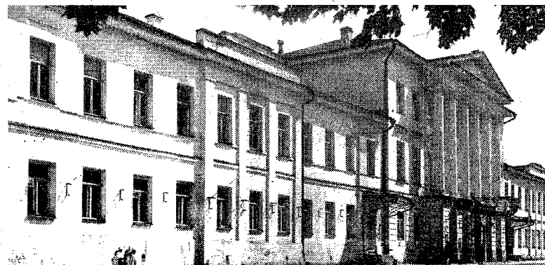
Здание исполкома Западной области в Смоленске, где 30–31.12.1918 г. состоялся I съезд КП(б)Б, объявивший о создании БССР.
